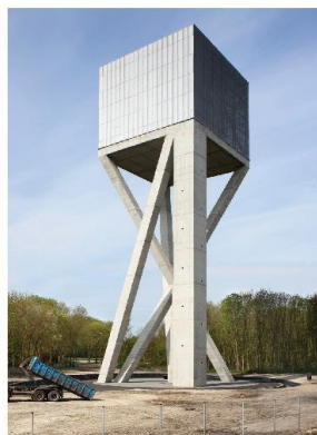
WIEŻA CIŚNIEN, BELGIA BUREAU VERS PLUS DE BIEN-ÊTRE
