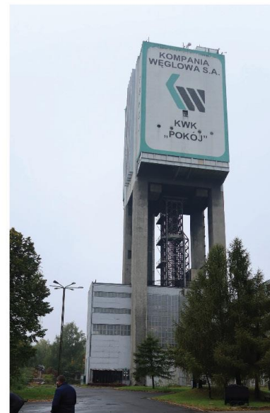
1. WIEŻA WYCIAGOWA SZYBU WANDA I BUDYNEK MASZYNY WYCIAGOWEJ
