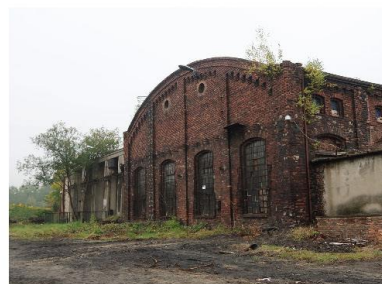
3. BUDYNEK MASZYNOWNI SZYBU „JAN KAROL”, BUDYNEK KOMPRESORÓW I PRZETWORNIC
